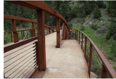
FIGURE 6 TRUSS WITH OUTBOARD PLATFORM
