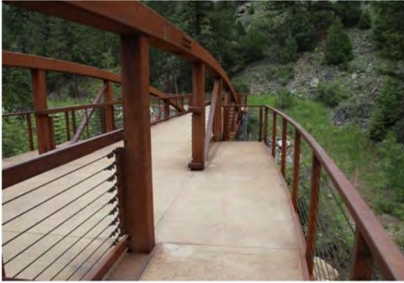
**FIGURE 6 TRUSS WITH OUTBOARD PLATFORM**
