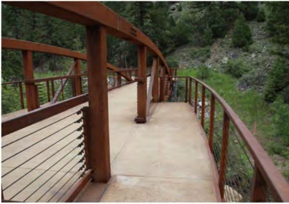
**FIGURE 6 TRUSS WITH OUTBOARD PLATFORM**
