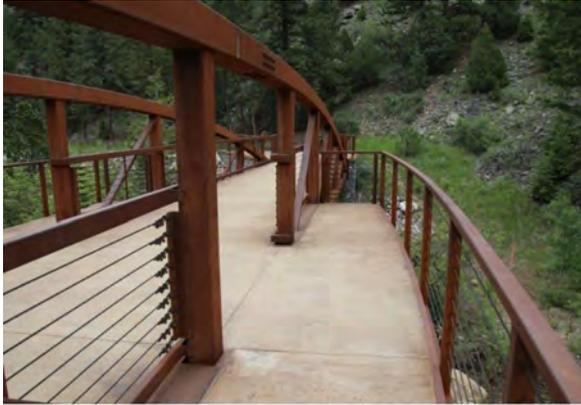
**FIGURE 6 TRUSS WITH OUTBOARD PLATFORM**
